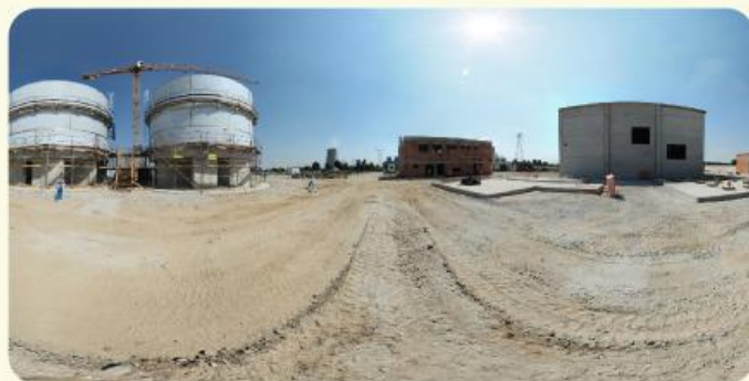
MP Production Sp. z o.o. (Grupa Messer) - zakład w budowie
