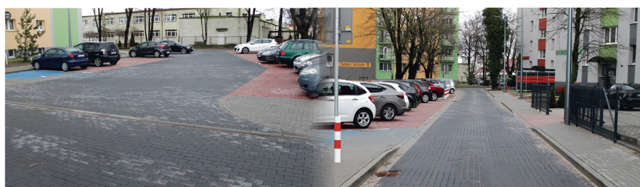
Przy odnowionej ulicy Żwirki i Wigury powstało kilkadziesiąt miejsc parkingowych
