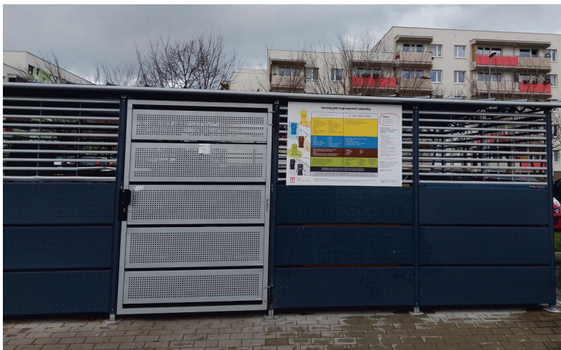
Na wiatkach śmietnikowych zamontowane są zasady segregacji odpadów
