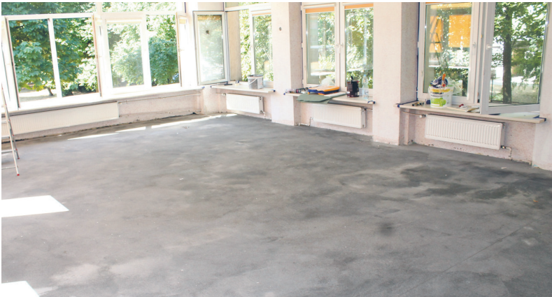
W Przedszkolu Samorządowym nr 5, w dwóch salach przeprowadzono gruntowną wymianę podłóg i posadzek.
