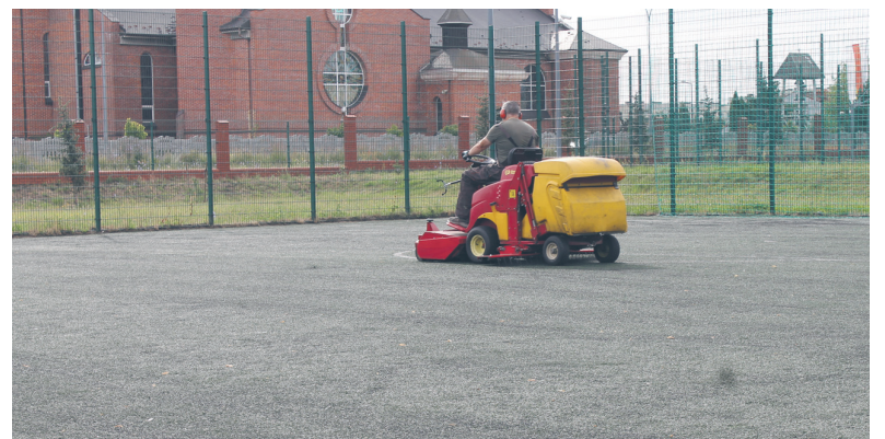
Wszystkie Orliki mają wyremontowane nawierzchnie.
