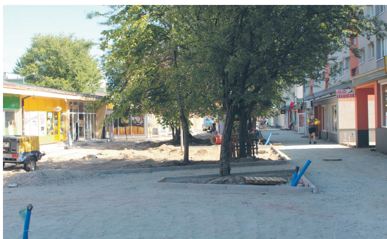
Wymiana nawierzchni deptaka.
