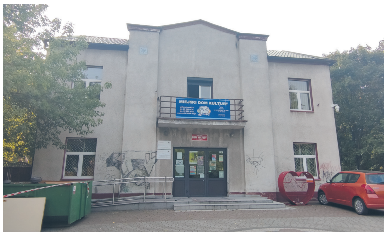
Rozpoczął się remont pomieszczeń na parterze Miejskiego Domu Kultury.
