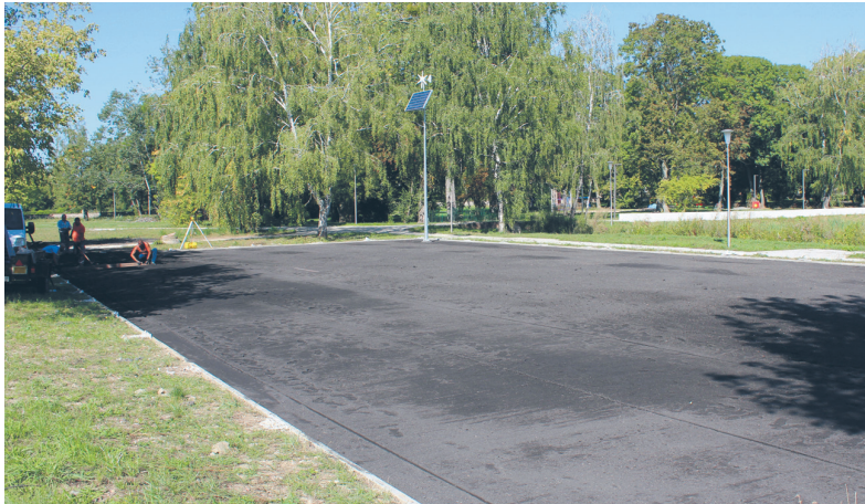
Aktualnie prowadzone są prace związane m.in. z budową kortu tenisowego.
