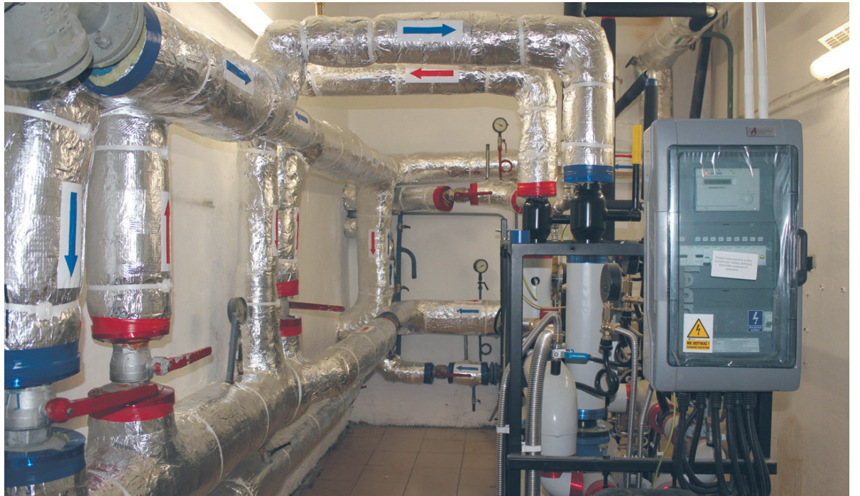
Największym przedsięwzięciem była modernizacja węzła ciepłego w Szkole Podstawowej nr 4.
