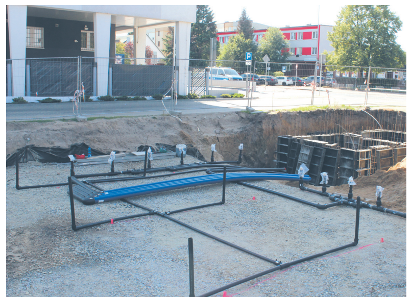
Budowa instalacji podziemnej dla fontanny.
